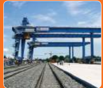
7- Козловой кран на железнодорожной базе.
